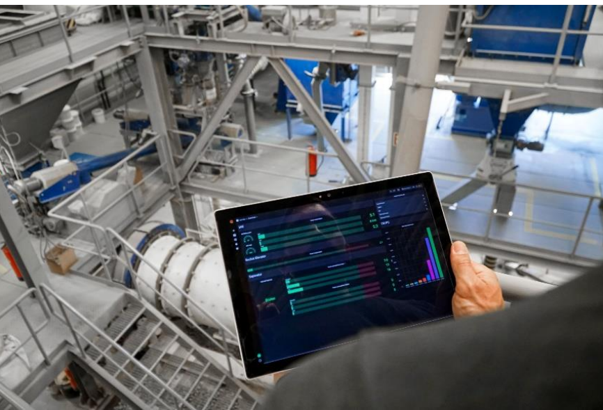
Zustandsüberwachung in der Gesteinsmahlanlage mit Mobilgerät
